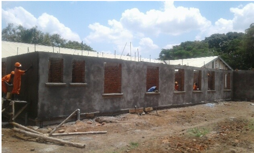
Werklui bezig met de uitbreiding van het gebouw van de operatie-afdeling
